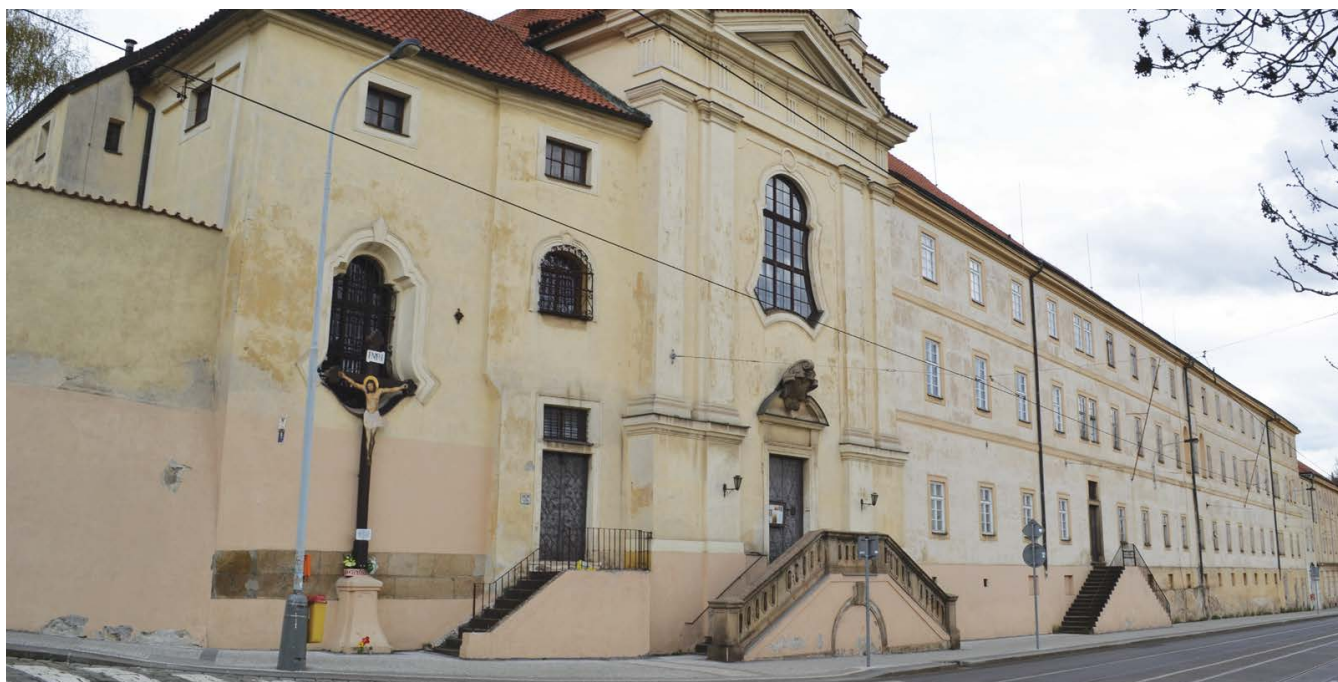
Kostel Panny Marie Sedmibolestné u alžbětinek byl vystavěn v letech 1722–1728. Stavba nového kláštera a nemocnice započala v roce 1726 a dokončena byla na počátku 30. let. Foto: Lukáš Malý
